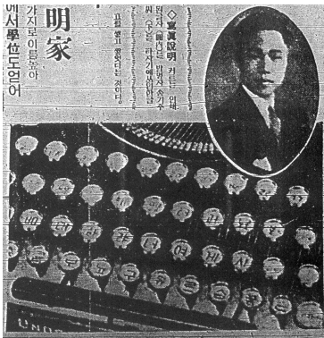
그림 6. 송기주(원 안)와 송기주 타자기의 자판. 완성된 음절글자처럼 보이는 글쇠들이 있는 것은 시프트를 눌렀을 때와 안 눌렀을 때 찍히는 자모를 붙여 썼기 때문이다. 예를 들어 가운데 줄의 '여' 글쇠를 그냥 누르면 'ㄹ', 시프트와 누르면 'ㅇ'(초성)이 찍히는 것으로 추정된다. "완성된 우리글 타자기 - 해외 각국 칠년 만에 송기주씨가 성공", 『동아일보』, 1934. 1. 24 석간, 2면.
