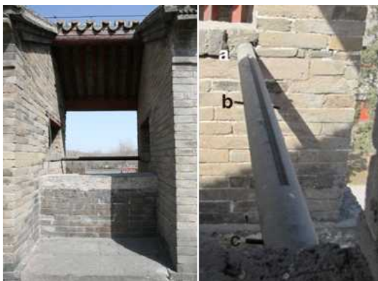
그림 2. 관성대 횡랑. 횡랑은 관성대 위의 두 외벽 사이에 설치되어 있다. 횡랑 윗면에는 물홈이 있고, 가로 횡랑의 세로 방향으로 세 개의 동근 핀이 꼽혀 있다.
