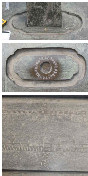
그림 8. 규 양 끝의 물흠과 눈금표시. 위로부터 남쪽 물흠, 북쪽 물흠, 7척 부근 눈금표시
